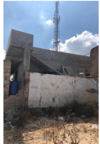
منزل ١، منظر لدرج المنزل المجاور الذي يستخدم أيضاً للوصول إلى سطح المنزل ١.
