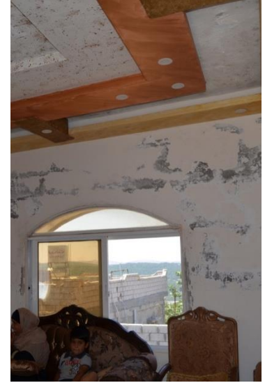
المنزل ١، منظر لغرفة الاستقبال المبنية حديثاً، وتلاحظ أن الأضرار الناتجة عن تسرب الماء قد ظهرت بسرعة في الجدران.
