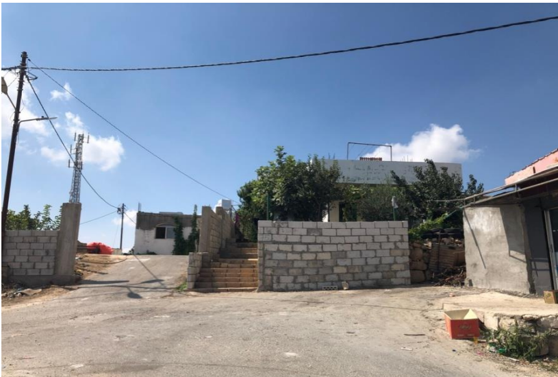
المنزل ١، منظر من واجهة الشارع يُظهر المنزل المجاور.
