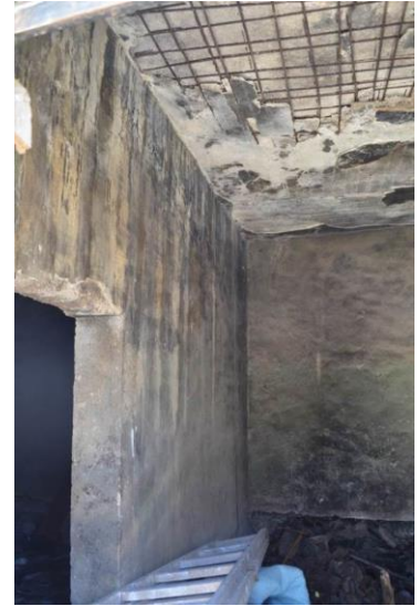
المنزل ١، منظر لإحدى الغرف القديمة التي تُستخدم حالياً لغايات التخزين.
